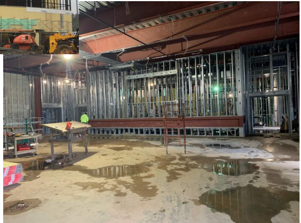
Theater – AV Booth Framing
